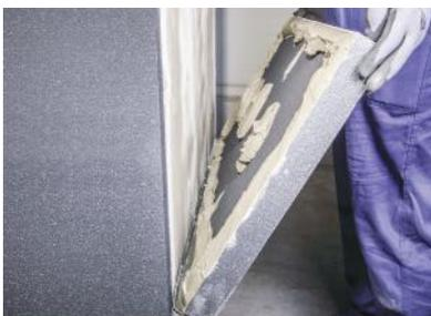
**Figure 1** Le panneau d'isolation thermique avec mortier adhésif appliqué sur la face arrière, est placé sur le profilé de base de manière à ce qu'il ne reste aucun espace.
