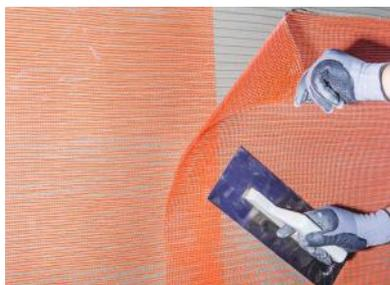
**Figure 2** Le filet en fibre de verre doit être appliqué sur la première couche d'enduit de surface encore humide, en exerçant une pression de haut en bas et en l'étirant largement, sans le plier et en le plaçant à égale distance du panneau isolant sur toute la surface. Au niveau des joints, les treillis en fibre de verre doivent toujours se chevaucher de 10 cm.
