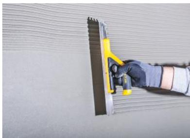
**Figure 1** Deux couches d'enduit de surface sont appliquées. Le mortier de plâtre Teknosistem préparé est appliqué de manière homogène sur la surface à l'aide d'une truelle en acier après avoir placé les panneaux d'isolation thermique Teknosistem collés et les chevilles.
