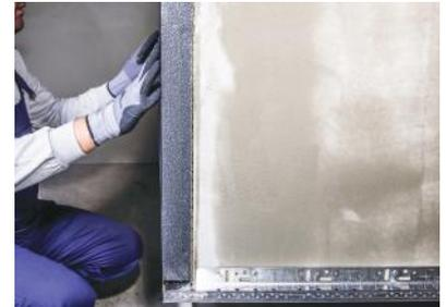
**Figure 3** Les dimensions des profilés de base, qui doivent être montés avec un espace de 2 à 3 mm entre eux, sont choisies en fonction de l'épaisseur du panneau d'isolation thermique à utiliser.
