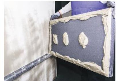
**Figure 3** Il faut faire attention à ne pas déborder des bords lors de l'application du mortier adhésif au dos du panneau isolant.
