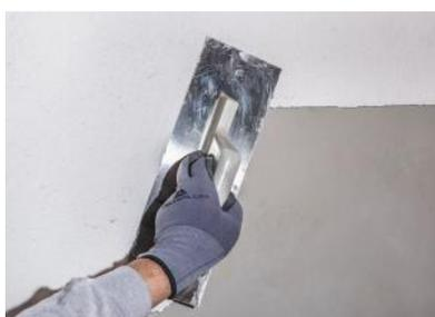
**Figure 1** L'enduit décoratif texturé minéral Teknosistem est appliqué sur la surface à l'aide d'une truelle.
