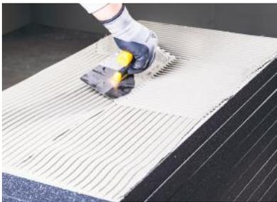
**Figure 1** Le mortier adhésif est appliqué sur l'ensemble du panneau d'isolation thermique à l'aide d'une truelle ou d'une truelle convenablement dentelée, en utilisant la méthode d'adhésion sur toute la surface si la surface est plane.
