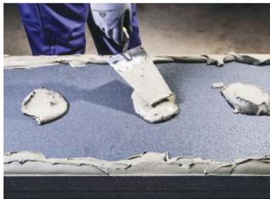
**Figure 2** Le mortier adhésif est appliqué sur le panneau d'isolation thermique à l'aide d'une truelle, en bande sur tous les bords du dos du panneau d'isolation thermique et en points au milieu, selon la méthode d'application par bandes et points s'il y a des différences de niveau ou des irrégularités sur la surface.
