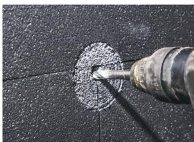
**Figure 2** La cheville est ouverte avec une perceuse. La taille du trou doit être 1 cm plus grande que la taille de la cheville.
