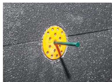
**Figure 3** Les chevilles sont placées dans les trous et les clous sont entièrement enfoncés.
