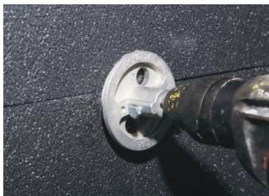
**Figure 1** La tête fraisée doit être ouverte à l'aide d'un appareil afin de positionner complètement la tête de cheville et d'éviter complètement l'épaississement.
