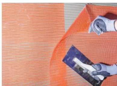
Figura 2 Plasa de armare trebuie așezată pe primul strat de tencuială de suprafață care nu s-a uscat încă, prin presare de sus în jos și întindere bine, fără pliuri și la o distanță egală de placa de izolație pe toată suprafața. Plasa de armare trebuie aplicată la îmbinări, suprapunându-se întotdeauna cu 10 cm.
