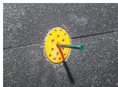
Figura 3 Diblurile sunt plasate în găuri și cuiele sunt complet înfipte.
