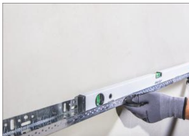
Figura 1 În prima etapă a aplicării, golurile, adânciturile și proeminențele dintre perete și profilul de bază Teknosistem sunt corectate cu ajutorul unor pene de diferite grosimi, iar suprafața este măsurată cu un nivel de suprafață.
