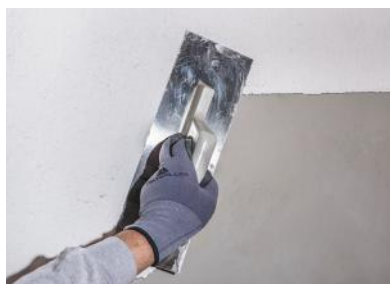
Figura 1 Tencuiala decorativă cu textura minerală Teknosistem se aplică pe suprafață cu o mistrie.
