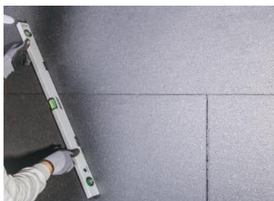
Figura 2 Verificarea nivelurilor plăcilor trebuie făcută cu un manometru sau o nivelă cu bulă.
