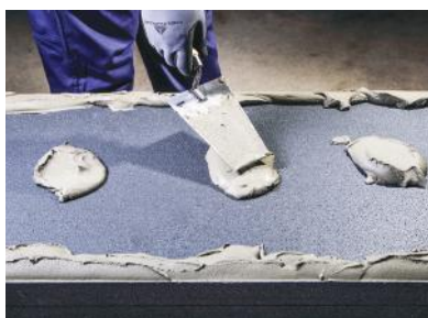
Figura 2 Dacă există diferențe de nivel sau curburi pe suprafață, se aplică „Metoda de aplicare a benzii și punctelor” și mortarul adeziv este aplicat pe spatele plăcii termoizolante în benzi continuu de-a lungul tuturor marginilor și în puncte din secțiunile din mijloc. Cu mistria.
