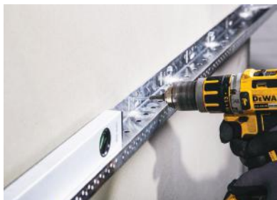
Figura 2 După procesul de aplatizare, profilele de bază Teknosistem sunt montate folosind dibluri.
