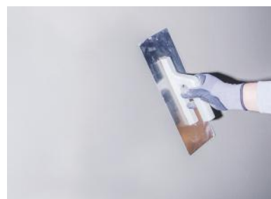
Figura 3 Aplicarea celui de-al doilea strat de mortar de ipsos este finalizată după ce primul strat este lăsat să se usuce ușor, în funcție de condițiile meteorologice blânde.
