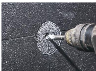
Figura 2 Locația diblului este găurită cu un burghiu. Lungimea orificiului trebuie să fie cu 1 cm mai mare decât lungimea diblului.
