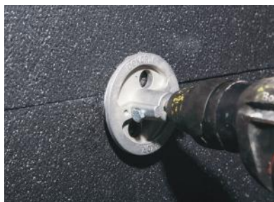
Figura 1 Pentru a amplasa exact capul diblului și a nu crea nicio grosime, capul de frezat trebuie deschis cu ajutorul aparatului.
