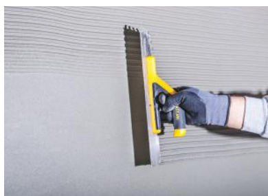
Figura 1 După lipirea și diblările plăcilor termoizolante Teknosistem, se aplică primul strat de tencuială de suprafață. Mortarul de tencuială Teknosistem preparat se aplică omogen pe suprafață în cantități egale folosind o mistrie de oțel.
