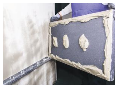
Figura 3 În timp ce aplicați mortarul adeziv pe spatele panoului de izolație, trebuie avut grijă să nu revărsați marginile.
