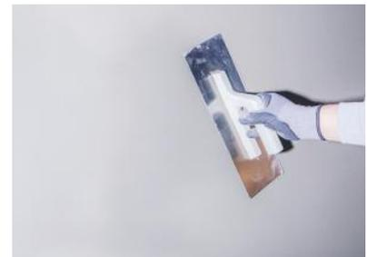
**Abbildung 3** Je nach Witterungsbedingungen wird der ersten Schicht Putzmörtel ausreichend Zeit zum leichten Abtrocknen gegeben, bevor die zweite Schicht Putzmörtel aufgetragen wird.
