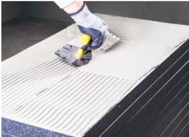
**Abbildung 1** Ist die Oberfläche eben, wird der Klebemörtel mit einer Kelle oder einer entsprechend gezahnten Kelle gleichmäßig auf die gesamte Wärmedämmplatte aufgetragen, wobei die Methode der Flächenhaftung verwendet wird.
