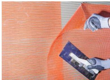
**Abbildung 2** Das Glasfasernetz wird auf den noch nicht getrockneten ersten Schicht Oberputz aufgebracht, indem es von oben nach unten gedrückt und straff gezogen wird, sodass es gleichmäßig vom Dämmstoff entfernt ist, ohne Falten zu werfen. An den Verbindungsstellen sollte das Glasfasernetz stets um 10 cm überlappen.
