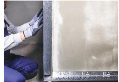
**Abbildung 3** Die Abmessungen der Sockelprofile, die mit einem Abstand von 2-3 mm zueinander montiert werden sollten, richten sich nach der Dicke der Verwendeten wärmedämmplatte.
