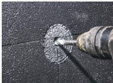
**Abbildung 2** Die Dübelstelle wird mit einer Bohrmaschine gebohrt. Das Bohrloch sollte 1 größer als der Dübel sein.
