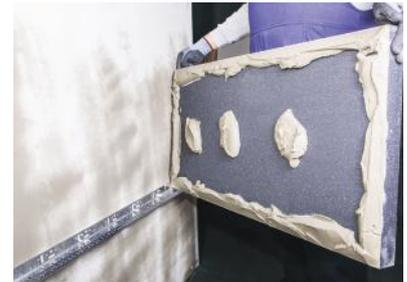
**Abbildung 3** Beim Auftragen des Klebemörtels auf die Rückseite der Dämmplatte sollte darauf geachtet werden, dass der Mörtel an den Rändern nicht überläuft.
