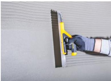
**Abbildung 1** Nach dem Verkleben und Befestigen der Teknosistem Wärmedämmplatten wird die erste Schicht Oberputz aufgetragen. Der vorbereitete Teknosistem Putzmörtel wird mit Hilfe einer stahlkelle gleichmäßig auf die Oberfläche aufgetragen. Die Anwendungsschicht des Oberputzes darf in jeder Schicht maximal 2 mm dick sein.
