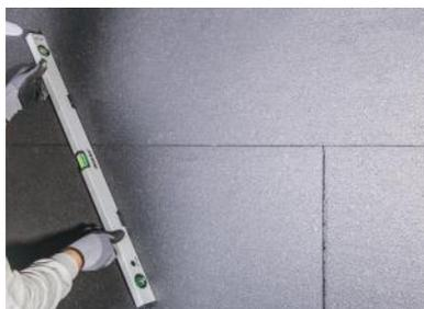
**Abbildung 2** Die Dämmplatten werden durch leichtes Verschieben an die Wand geklebt, um sicherzustellen, dass sie vollständig Kontakt zur Wand haben. Die Ebenheit der Platten muss mit einer Richtschnur oder Wasserwaage überprüft werden.
