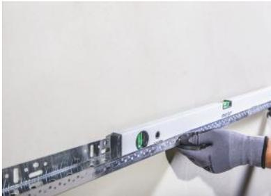
**Abbildung 1** Die Montage des Teknosistem Sockelprofile sorgt dafür, dass das Wärmedämmungssystem ausgewogen und glatt ist. Um mögliche Unebenheiten auf der Oberfläche auszugleichen, werden Spalten, Vertiefungen und Überstände zwischen wand und Unterprofil mit keilen unterschiedlicher Dicke korrigiert, sodass die Fläche nivelliert wird.
