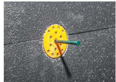
**Abbildung 3** Dübel werden in das gebohrte Dübelloch gesetzt die Dübelnägeln werden vollständig eingeschlagen.
