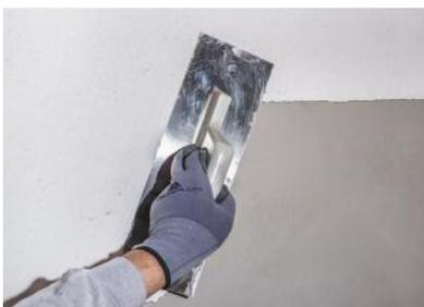
**Abbildung 1** Der Teknosistem Mineral Dekorputzmörtel wird mit einer Kelle auf die Oberfläche aufgetragen.
