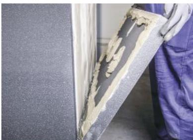
**Abbildung 1** Die Wärmedämmplatte, die auf der Rückseite mit Klebemörtel versehen ist, sollte ohne Lücken auf das Sockelprofil gesetzt werden.
