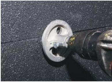
**Abbildung 1** Um den Kopf des Dübels, der je nach Wandbeschaffenheit ausgewählt werden muss, vollständig einzulassen und keine zusätzliche Dicke zu verursachen, ist es notwendig, mit einem geeigneten Werkzeug eine Senkbohrung durchzuführen.
