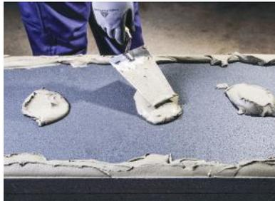
**Abbildung 2** Bei Unebenheiten oder Höhenunterschieden auf der Oberfläche wird der Klebemörtel in Form von Streifen entlang der Ränder und in Punkten im Mittelbereich der Rückseite der Wärmedämmplatte aufgetragen. Hierbei wird die Methode der Streifen-und Punktapplikation verwendet.
