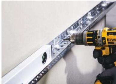
**Abbildung 2** Nach der Nivellierung werden die Teknosistem Sockelprofile mithilfe von Dübelmontage fixiert.
