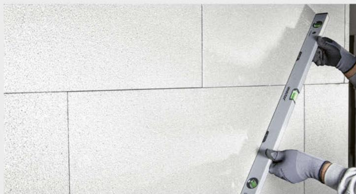
Teknosistem Teknopor EPS ısı yalıtım levhası, genleştirilmiş polistiren sert köpük, %98'i hava ve %2'si petrol türevi plastikten oluşan termoplastik, kapalı gözenekli, genellikle beyaz renkli ekonomik ve hafif bir ısı yalıtım malzemesidir.
